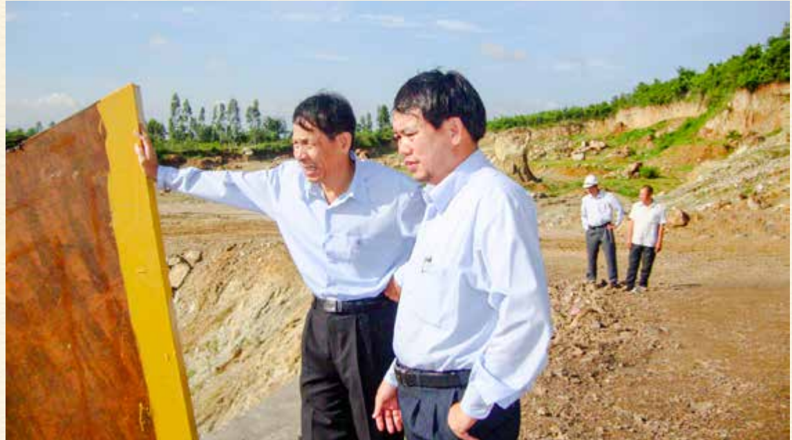
Thực địa công trình mỏ đá lô 3+4.
