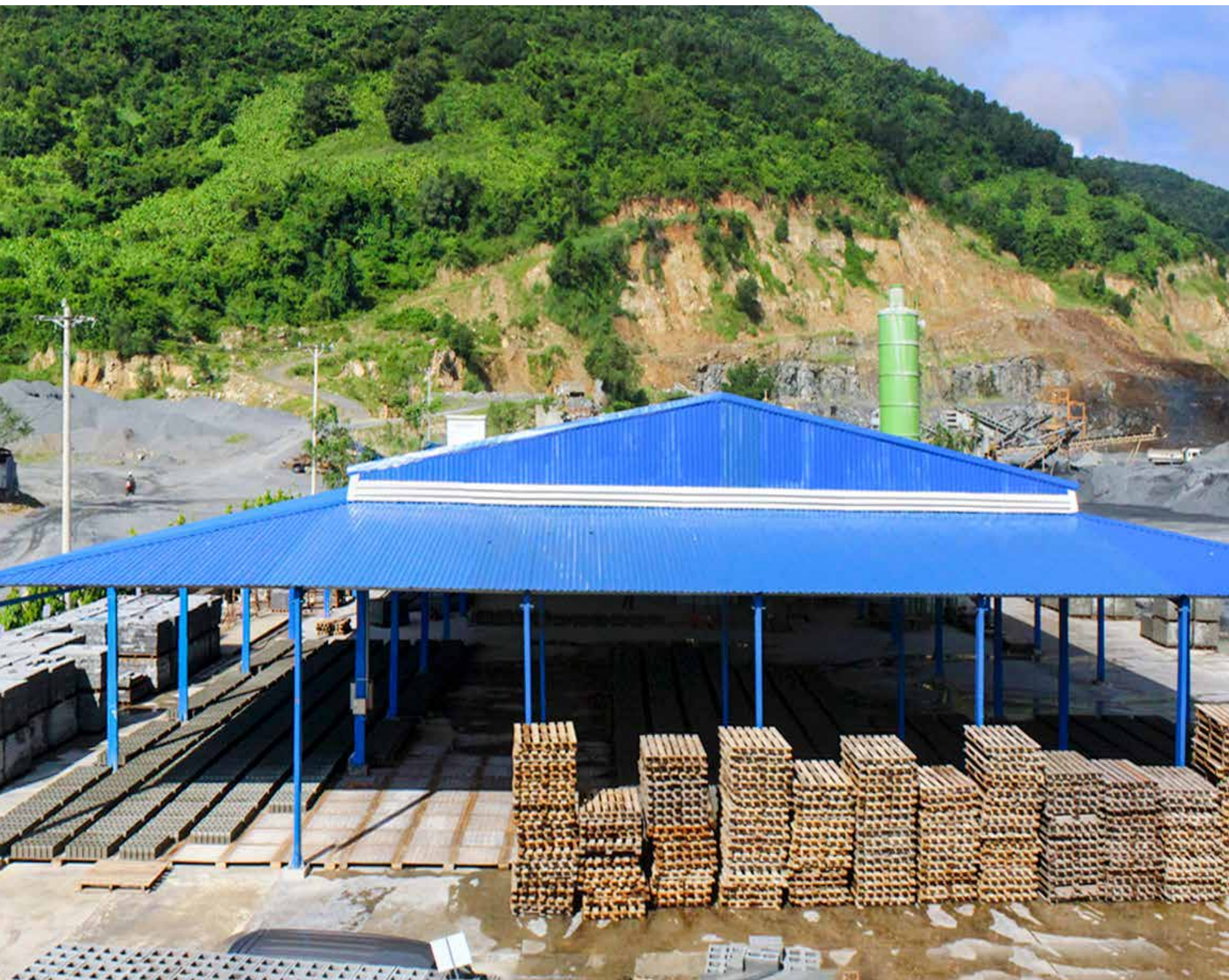
Nhà máy gạch ngói không nung của Công ty cổ phần Thành Chí.
