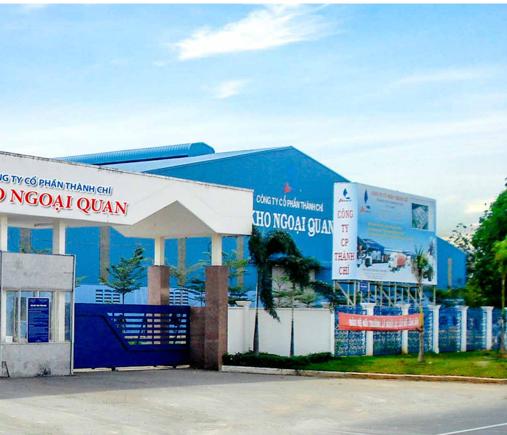
Kho bãi ngoại quan của Công ty cổ phần Thành Chí Địa chỉ: Đường 13, KCN Phú Mỹ 1, thị trấn Phú Mỹ, huyện Tân Thành.
